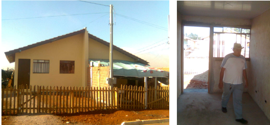
IMAGEM IV: Casas geminadas e sala conjugada com cozinha de residência em construção no Morádias Aquarela, Fonte: Autores.
